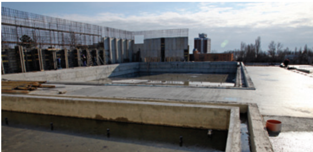
Utánpótlás-nevelő központ is épülhet a nyárra elkészülő uszoda mellé
